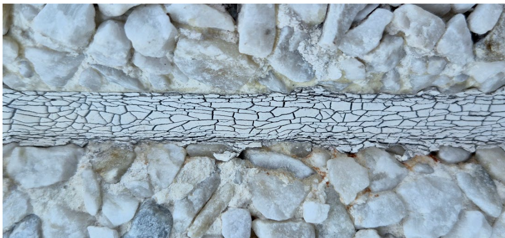
Figur 7.13 Fogmassa där det mjukgörande och UV-skyddande tillsatserna börjat mista sin tekniska funktion (foto: M Theorin).
