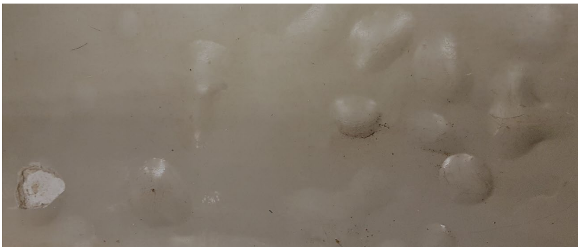
Figur 7.8 Epoxigolv som applicerats på dåligt rengjorda ytor och hög fukthalt i underlaget kan få blåsbildning med upp till 100 mm stora blåsor (foto: M Theorin).
