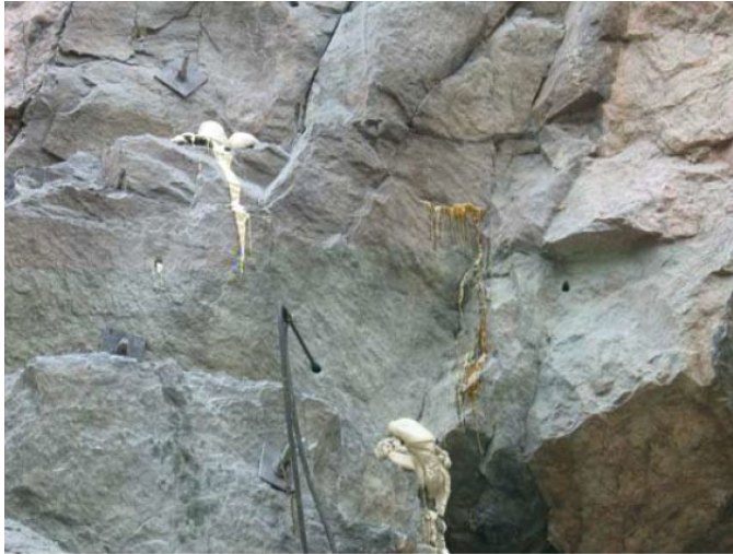
Figur 7.6 PU-skum som bildas och tränger ut vid kontakt med fukt (foto: M Theorin).
