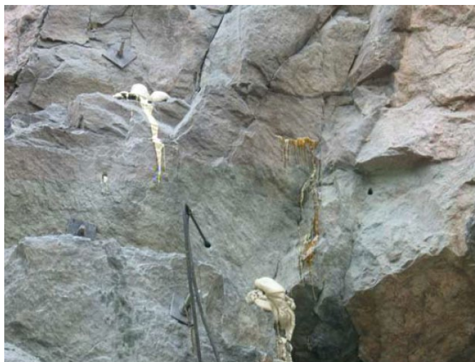
Figur 7.6 PU-skum som bildas och tränger ut vid kontakt med fukt.
