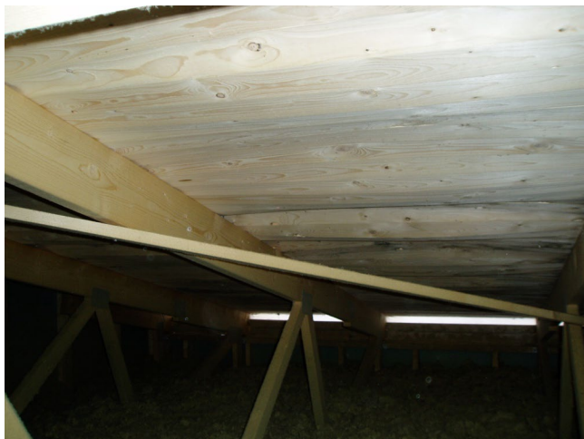
Figur 4.4.1. Skada av bristfällig tätning upp till vinden under produktionsskedet, vilket föranledde byte av ett falsat plåttak. (Foto: E Gustafsson)
