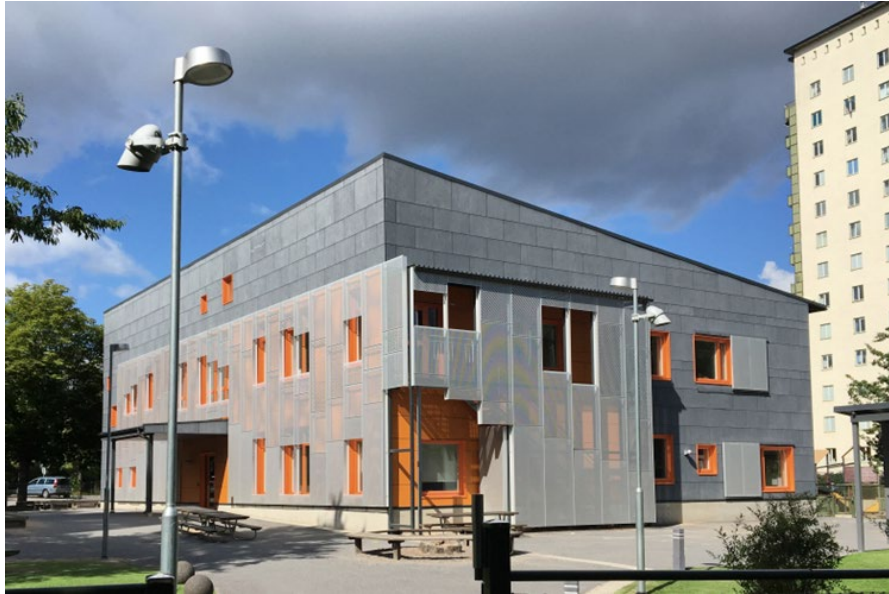
Figur 8.14 Nybyggd förskolebyggnad med små fönster och avskärmning av dagsljus från fasadelement. I byggnaden finns rum som inte uppfyller BBR:s dagsljuskrav trots att byggnaden i stort sett inte skymms av omkringliggande byggnader. (Foto: Paul Rogers).
