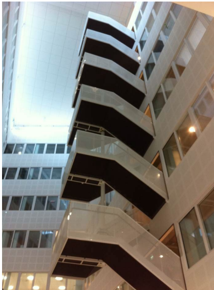
Figur 8.13 Minskad glasarea i nybyggt kontorshus som i kombination med små gårdar resulterar i mycket låga dagsljusnivåer i intilliggande kontorsutrymmen. (Foto: Paul Rogers).
