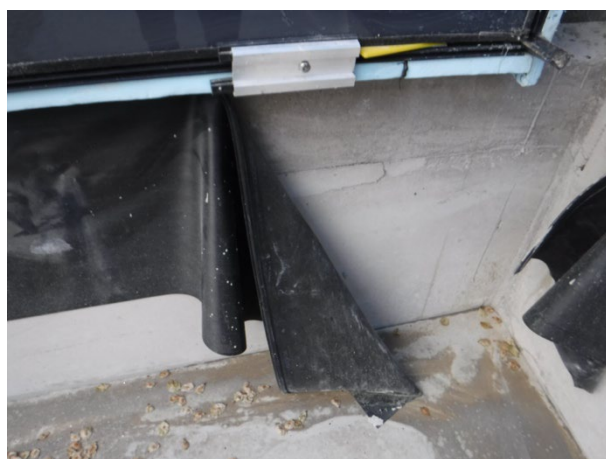
Figur 3.6.1 Gummidukar, tänkta som sekundärtätning, finns ofta färdigmonterade under dörrar och fönsterpartier. Det är ofta oklart hur det ska monteras. (Foto: E Gustafsson)
