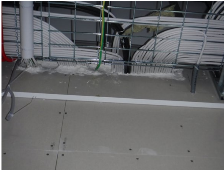
Figur 3.6.2 Omfattande kabelgenomföring tätad med fogmassa. Det finns bättre lösningar (Foto: E Gustafsson)
