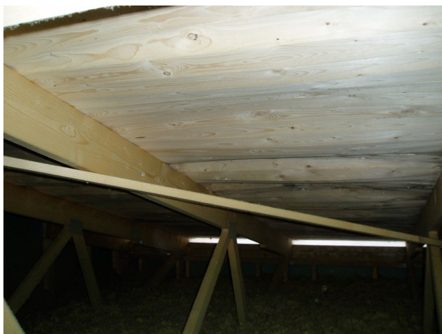
Figur 3.4.1. Skada av bristfällig tätning upp till vinden under produktionskedet, vilket föranledde byte av ett falsat plåttak. (Foto: E Gustafsson)
