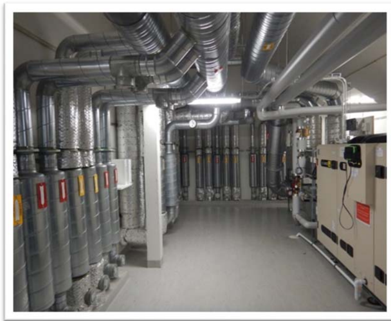
Figur 3.2 Bild som åskådliggör hur mätproblematiken kan lösas om det finns bra med plats i fläktrummet. Fläktrummet är ett exempel från Vätterhem, men ofta finns inte möjlighet att erhålla så stora fläktrum. (BeBo 2019)
